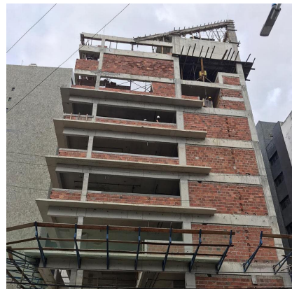
Nova sede em construção
